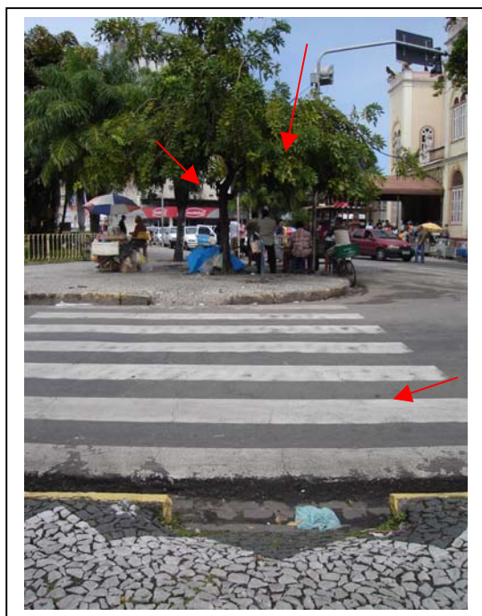
Figura 03 – Rampa e faixa de pedestre, e obstrução nos passeios.
