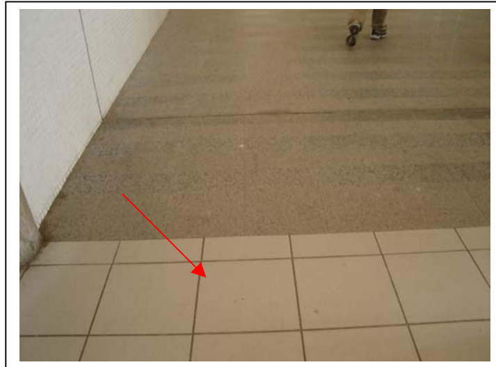
Figura 14 – Piso existente na circulação.
