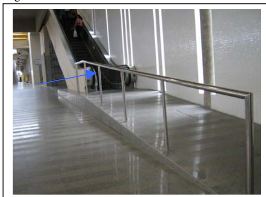
Figura 20 – Acesso à escada rolante.
