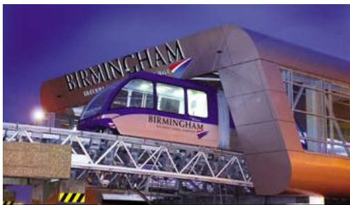
Figura 1 – Sistema APM tracionado a cabo do aeroporto de Birmingham (DCC DOPPELMAYR CABLE CAR GMBH & CO, 2007a)
